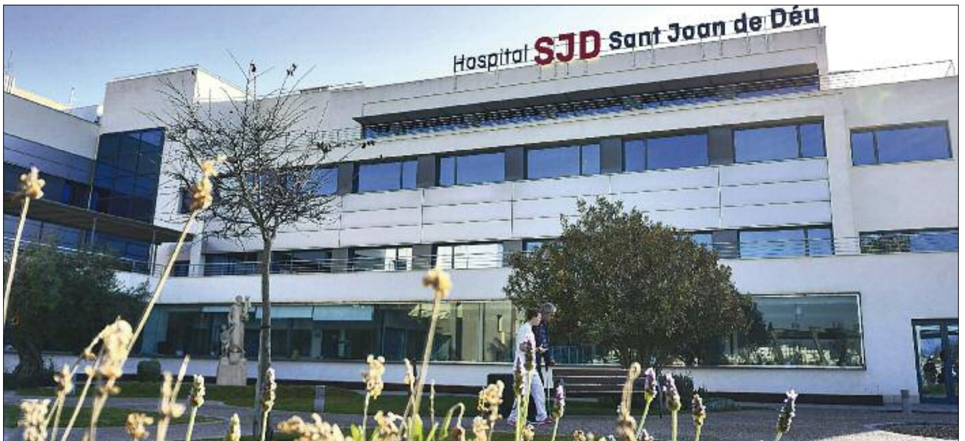
Vista general de Hospital Sant Joan de Déu en Palma.
